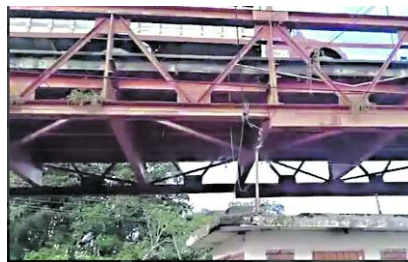
Comenzaron los trabajos de mantenimiento en el puente entre los municipios de La Unión y La Victoria.
