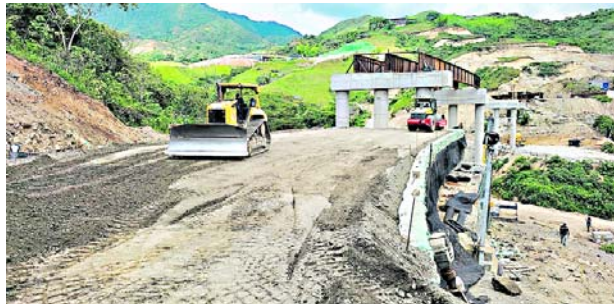
Las obras se han retrasado debido al mal clima que ha impedido la terminación de la variante.
