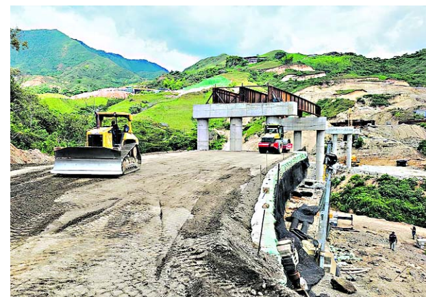
Las obras en el tramo Mojarrales – Popayán tienen un avance del 83%.
