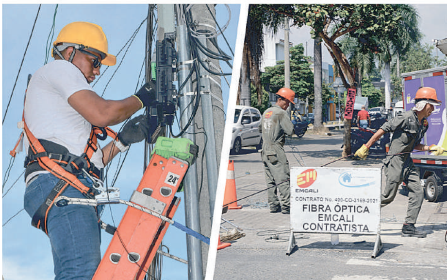
Instalación de fibra óptica en las comunas de la ciudad.
