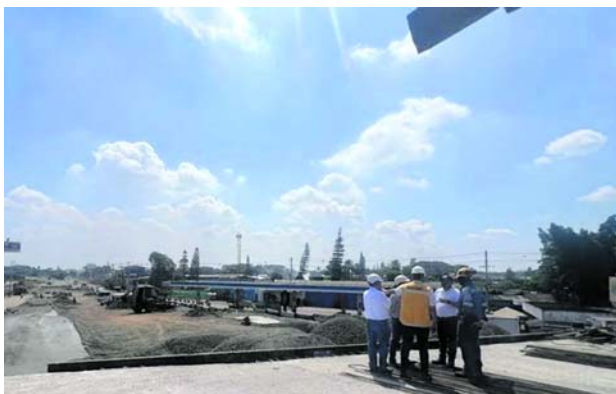
El gobierno departamental supervisó el inicio de las obras del puente de Juanchito.
