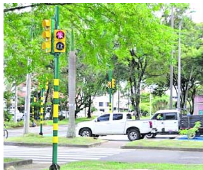
Según Hernández, de los 200 semáforos proyectados, solo se instalaron 58, y de esos, solo seis estarían funcionando adecuadamente.
