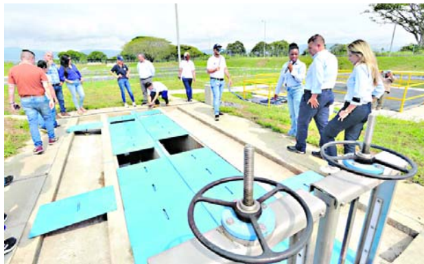
La moderna ptar ayudará a evitar la contaminación de la laguna de Sonso.
