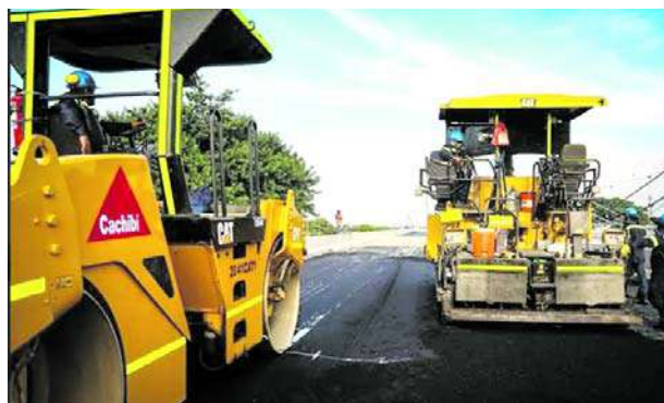
Una vez terminado el pavimento sobre la calzada norte del nuevo puente de Juanchito, será habilitada a los usuarios de la vía.
