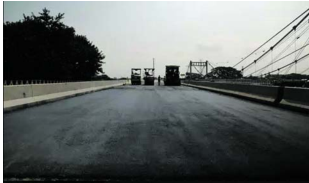
La calzada norte del nuevo puente de Juanchito está lista para su habilitación.
