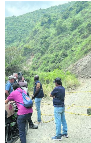
El derrumbe se presentó en el sector de “Los Chorros”, zona rural de Palmira.
