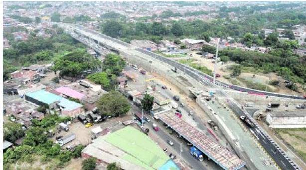
Ya fue habilitada la calzada norte del nuevo puente de Juanchito.
