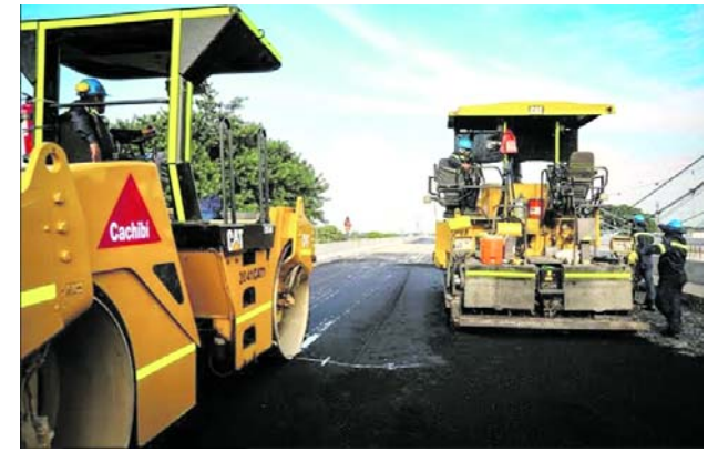
Comenzó la intervención con asfalto en la calzada norte del puente de Juanchito.
