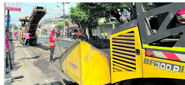
La construcción de cicloinfraestructura también está en marcha, con una cuadrilla trabajando en la calle 5, entre carreras 72 y 80.
