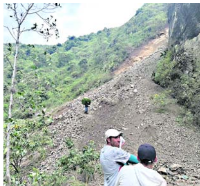
Ante la llegada de la lluvia, la CVC alertó sobre los cuidados que hay que tener en zonas donde se han presentado derrumbes como la zona rural de Palmira.
