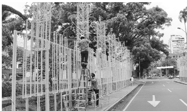
Los trabajos en las luces continúan.
