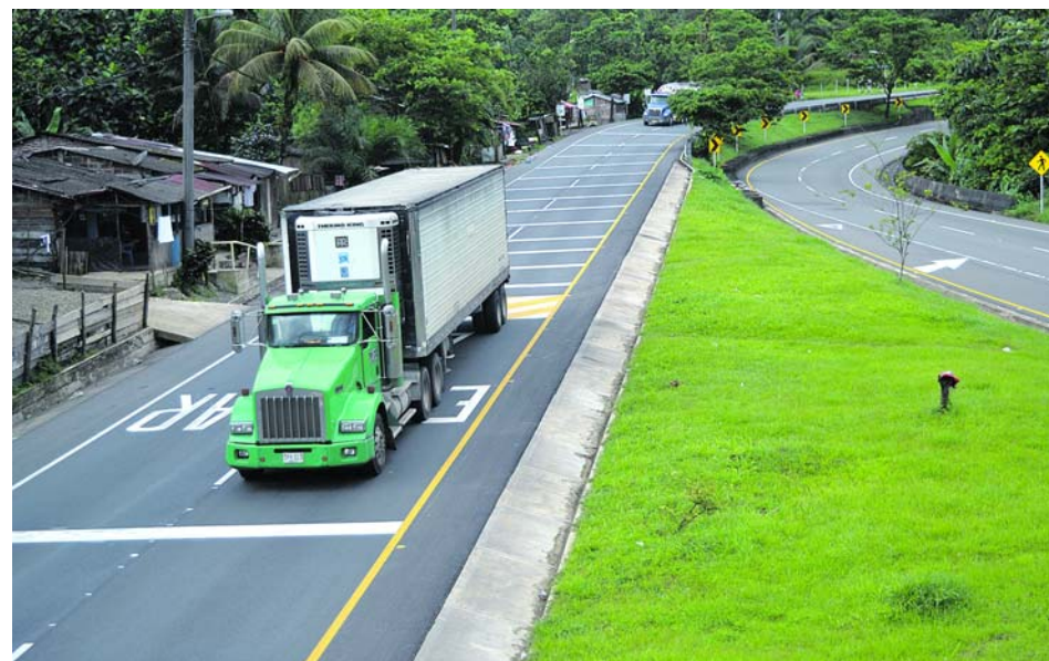
Importantes obras de infraestructura como la doble calzada se adelantan en Buenaventura.
